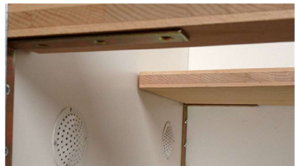
(Metallwinkel z.B. wie unter 2. am Gitter angebracht können die Etagen stützen)
